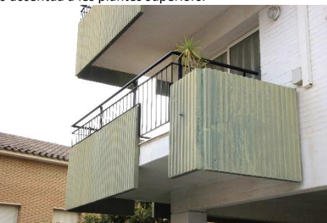
Balcó del bloc A-8 on veiem les baranes metàl·liques i les peces de formigó pintades.
