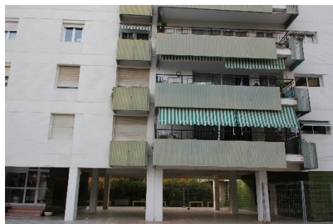
Tendals als balcons del bloc A-9.
