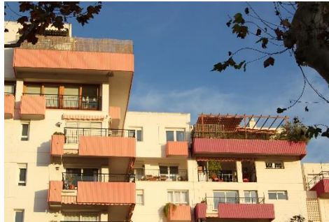
Imatge de la part superior dels blocs A-4 i A-3 on veiem la varietat de les composicions de façana, que s'accentua a les plantes superiors.
