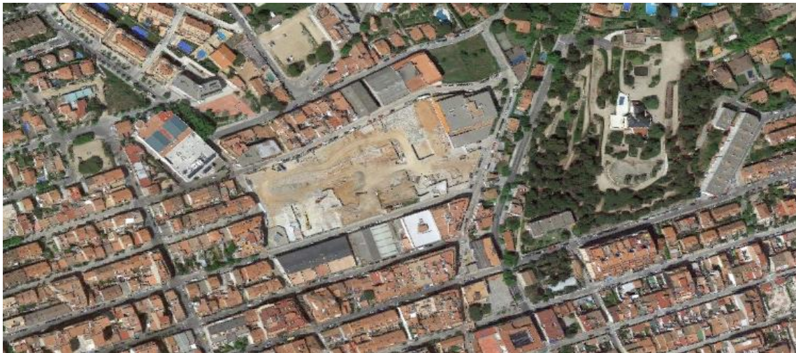
Estat previ a les obres d'urbanització de la plaça i de la construcció dels edificis d'habitatges.
