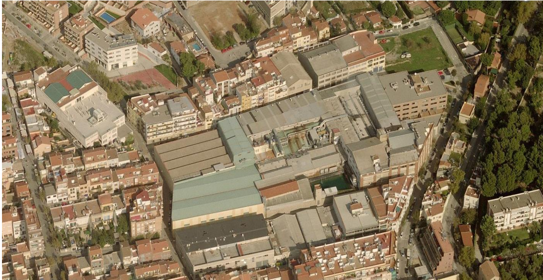
Imatge de l'àmbit amb les antigues instal·lacions de la DOGI
