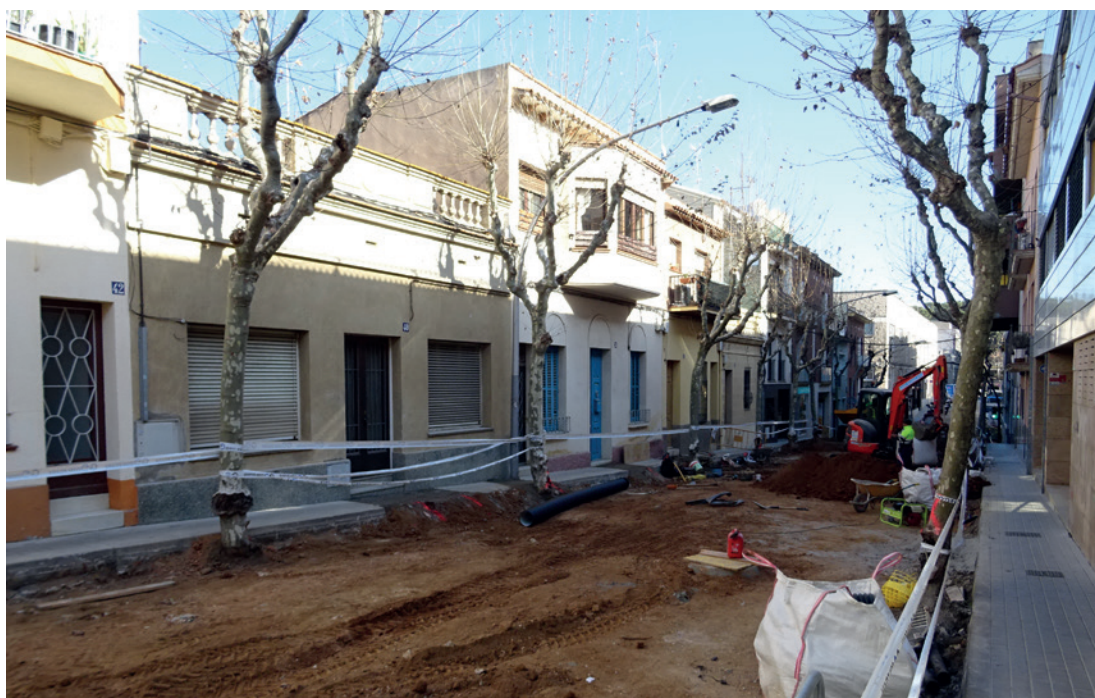
▲ El tram on s'actua, després d'haver-hi retirat l'asfalt. CEDIDA
