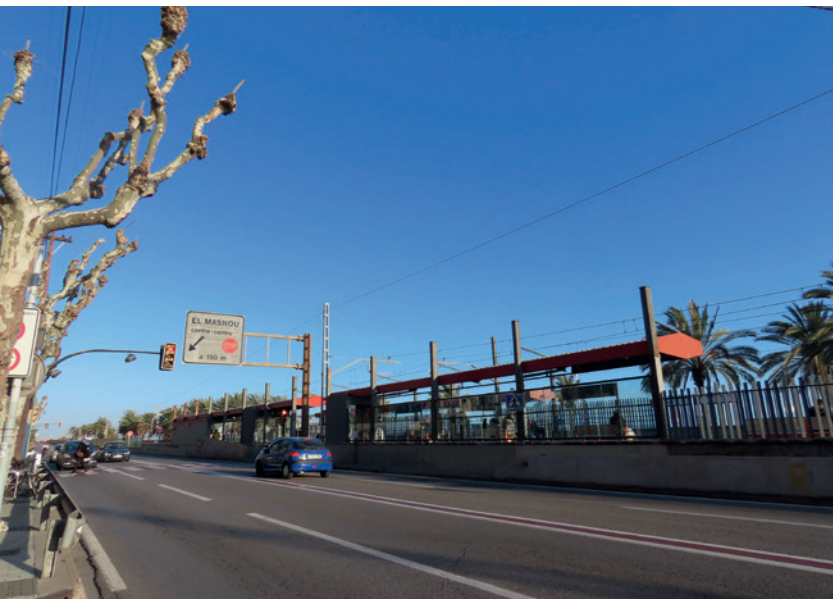
▲ Caldrà anul·lar un dels quatre carrils de l'N-II per executar les obres.
