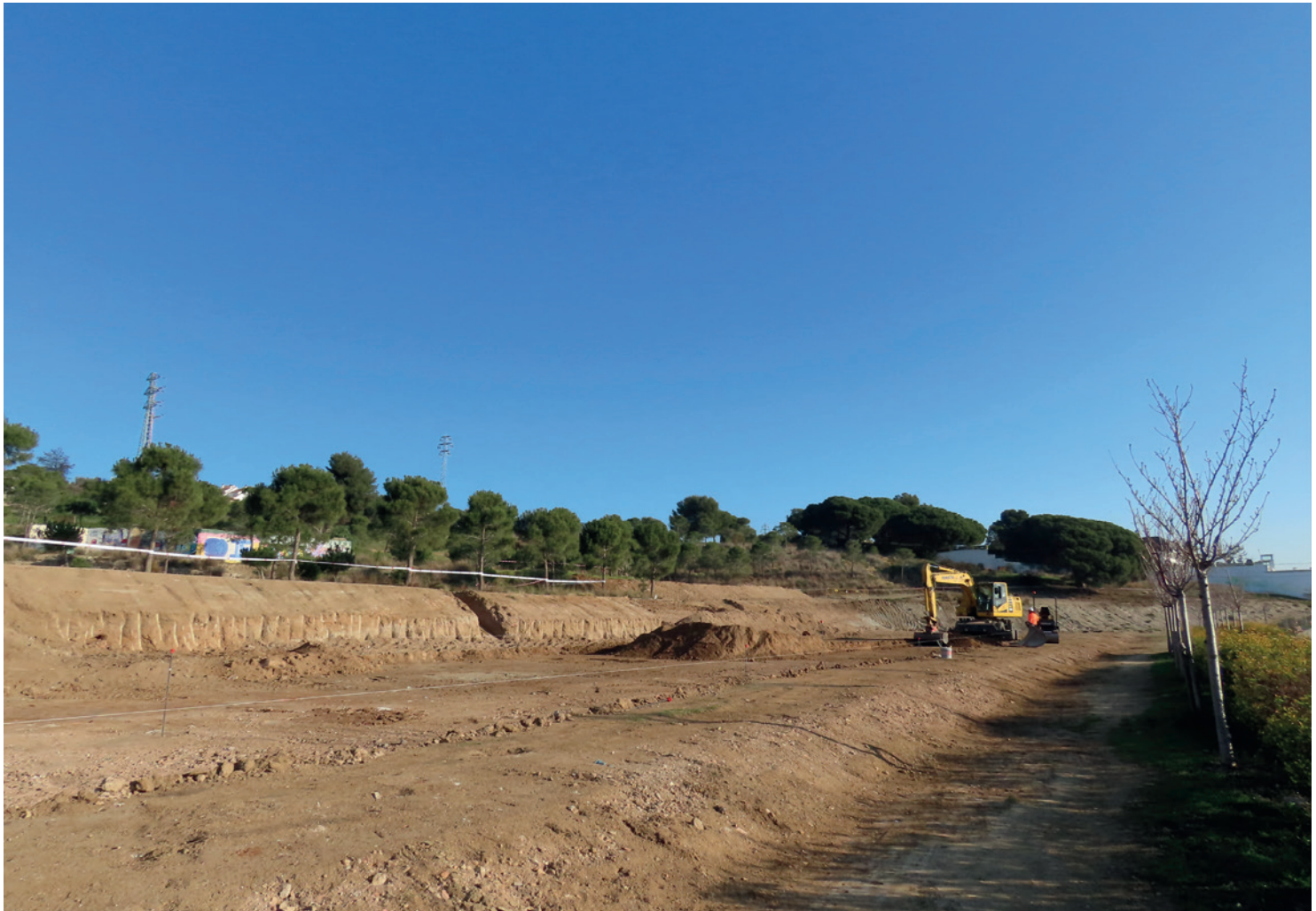
▲ Una excavadora anivella el terreny. DOMÈNEC CANO
