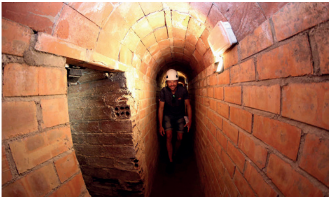
▲ Al subsol del Masnou hi ha quilòmetres de galeries. CEDIDA
