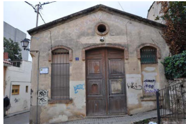
Imatge 27: Vista façana nord
