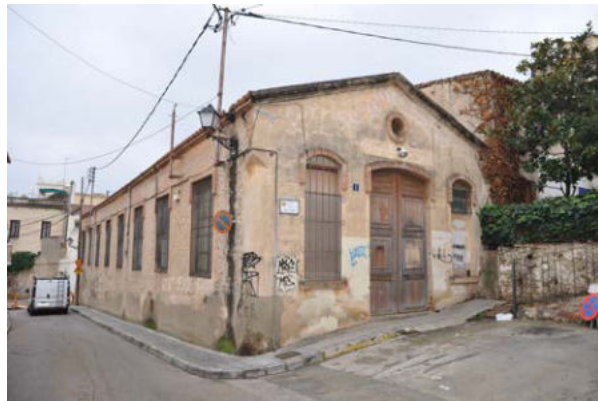
Imatge 26: Vista façana nord
