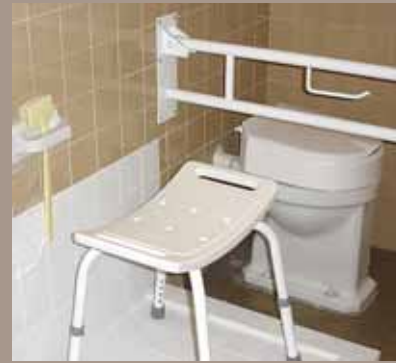
Detall d'un bany que ja ha estat adaptat.
