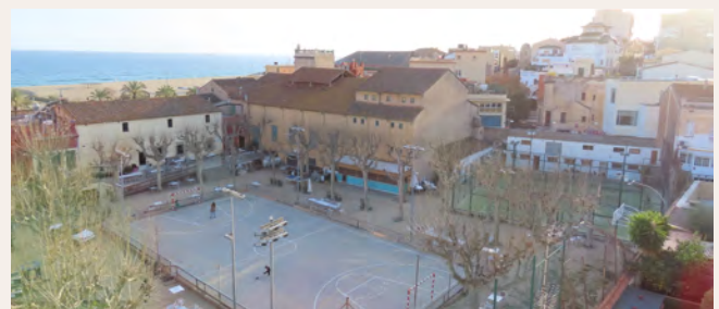
▲ El vestidor i el magatzem es troben a l'edifici blanc de la dreta. DOMÈNEC CANO
