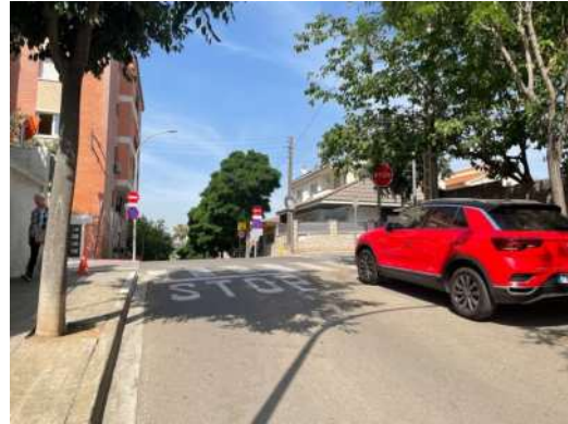
Imatge 58. S'ha reforçat la senyalització horitzontal d'estop i línia de detenció (2022)
