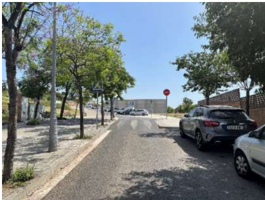
Imatge 96. Pas elevat a c. Montevideo (avís de ressalt amagat pels arbres)
