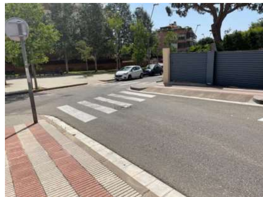
Imatge 87. Pas no accessible: gual de vehicles amb excessiu pendent, i pas de vianants desplaçat cap a la cantonada no adaptada per no destorbar el gual).
