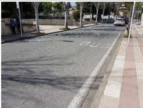
Imatge 157. Parada d'autobús en secció amb pal, sense bancs ni marquesines.
