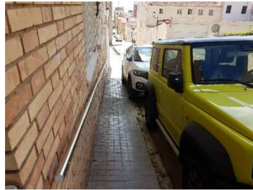
Imatge 136. Vorera inaccessible, c. Capitans Comellas.
