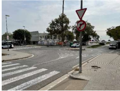
Imatge 102. Itinerari rectilini en sentit N-II des de Torrent de Can Gaió. Sobreample en el ramal de c. Agricultura, remanent de l'antiga configuració bidireccional del ramal (actualment unidireccional de sortida de rotonda)
