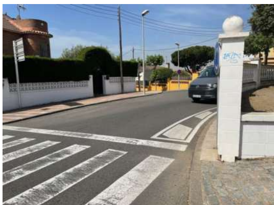
Imatge 73. Ample del zebrat inferior a 1 metre, es mantenen 5,5 m de calçada (2022)
