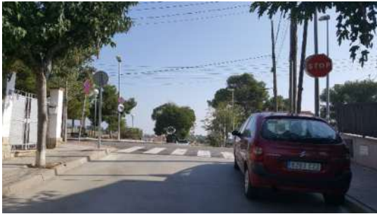
Imatge 49. Ramal d'incorporació amb manca de pintat de línia de detenció i visibilitat limitada (2017)
