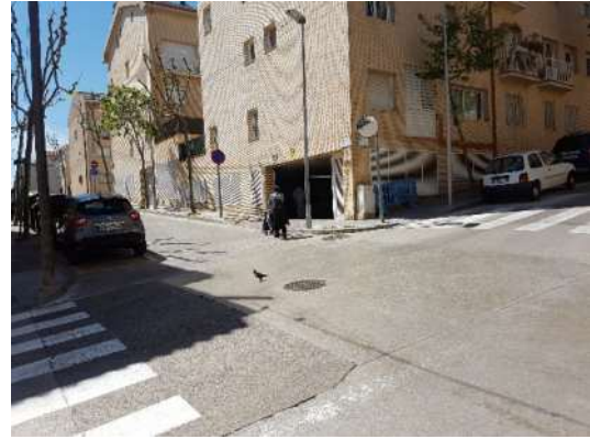
Imatge 89. Exemple 2 de pas mancant per coincidència amb gual d'aparcament.
