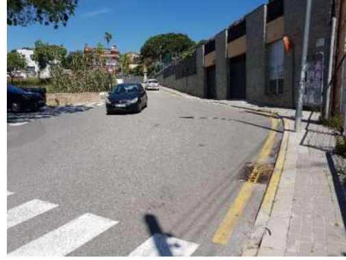
Imatge 146. Vista del ramal descendent i zona de sobre ample on hi ha detencions.
