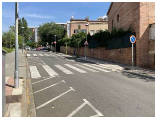
Imatge 91. Mesures de millora de la visibilitat prèvia dels passos, establint aparcament de motocicletes en comptes d'aparcament de turismes (av. Pau Casals).
