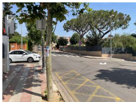
Imatge 68. Creació de pas de vianants elevat al ramal nord de pg. Pau Casals (2022)
