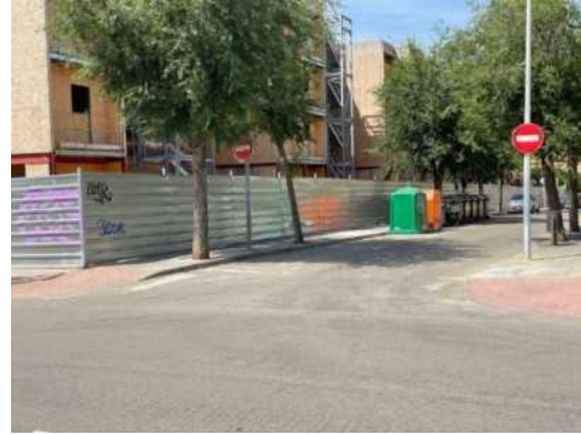
Imatge 77. Pas esborrat en zona d'obres c. Dr. Olivé Gumà.
