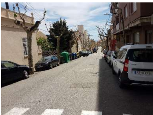
Imatge 149. Vista del tram alt. Calçada sense definició d'espais i amb sobreample.
