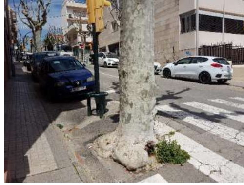
Imatge 152. Exemple de pas de vianants no accessible per graó i obstacles.
