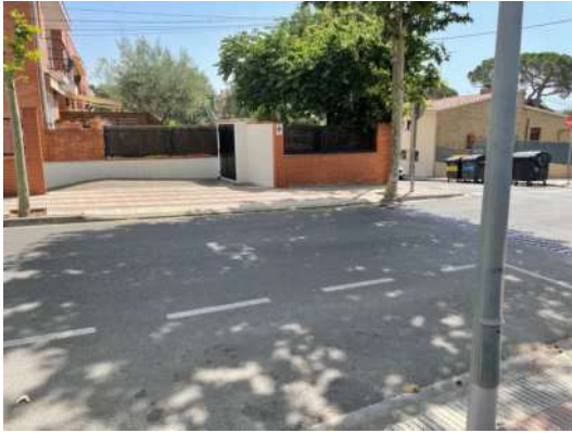
Imatge 88. Exemple 1 de pas mancant per coincidència amb gual d'aparcament.
