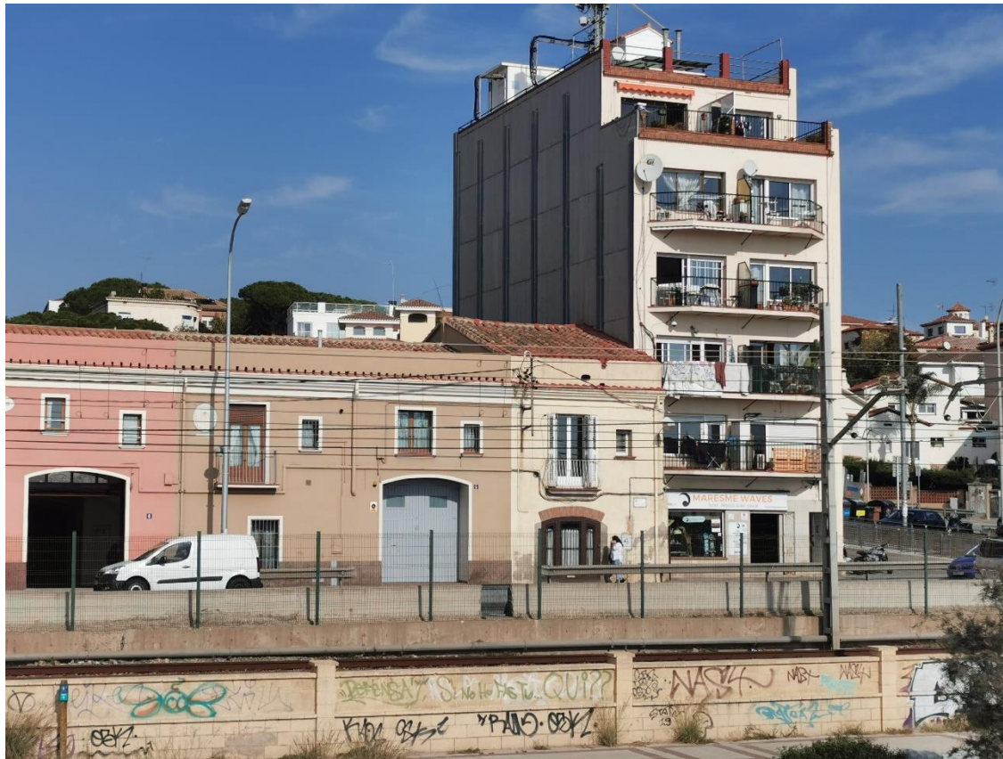
Vista de l'extrem est del conjunt.
