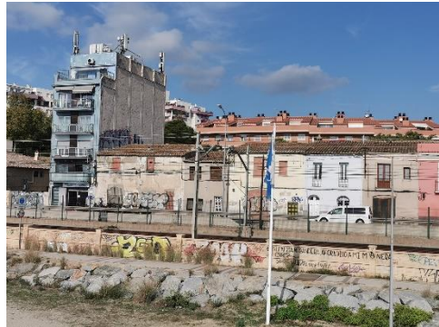
14. Vista de la banda oest del conjunt. A l'extrem esquerre l'edifici en altura del número 12, seguit del números 11, 10, 9, 8 i 7.
