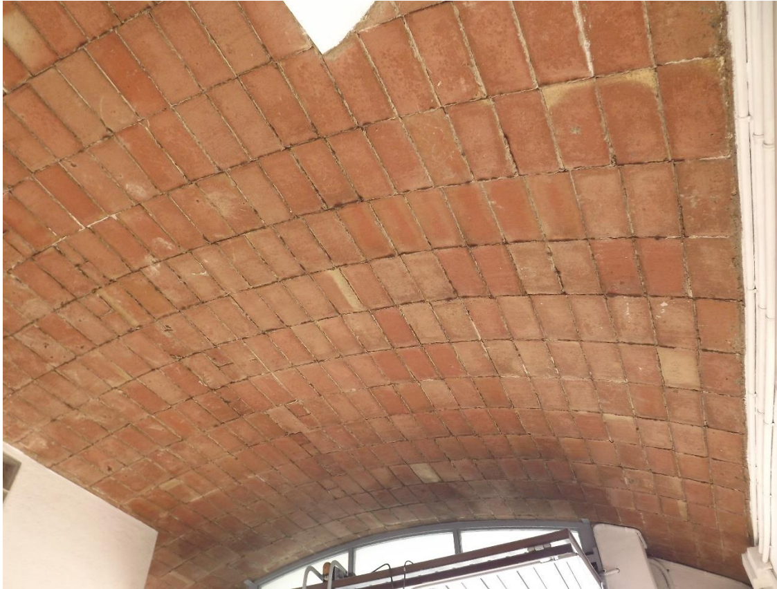
Detall de la volta a l'entrada de la casa núm. 5.
