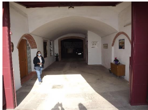
06. Vista de l'espai d'entrada a l'hostal, amb la gran volta ceràmica i l'entrada a les cavallerisses al fons. Probablement els arcs de les parets laterals eren obertures que permetien l'accés a les cases veïnes quan el conjunt funcionava de manera unificada com a hostel.
