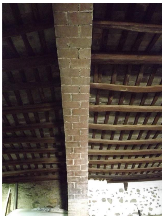
Detall de l'arc de fàbrica i de l'embigat de fusta.
