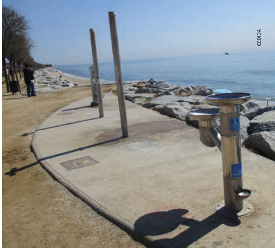
Una de les noves fonts instal·lades al passeig Marítim.
