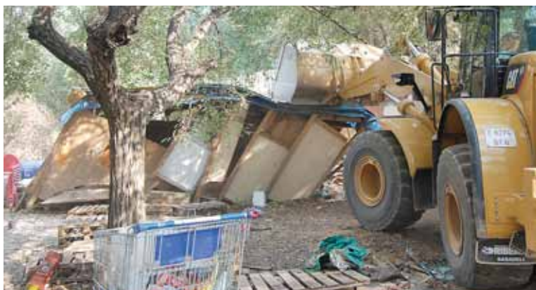
Una de les màquines que van enderrocar les construccions.
