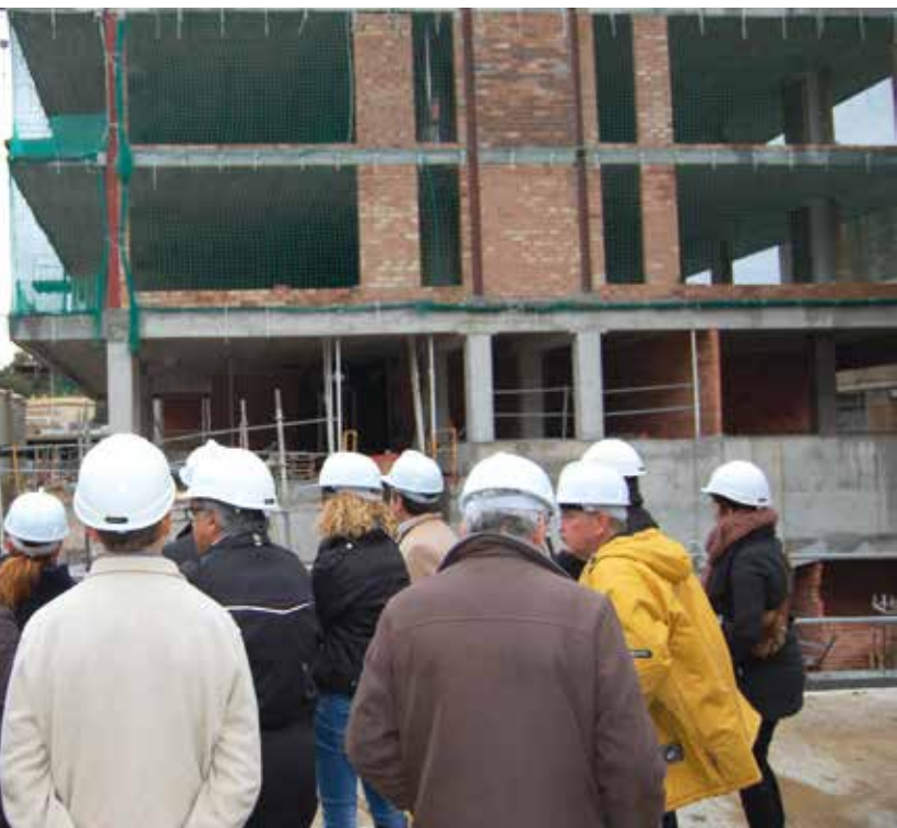
Membres del consistori i tècnics de la promotora immobiliària durant la visita a les obres.
