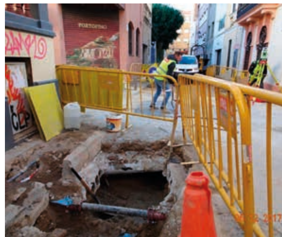
Obres al carrer del Dr. Agell.
