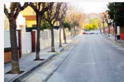
Voreres reparades al carrer de Bilbao. RAMON BARRAGÁN
