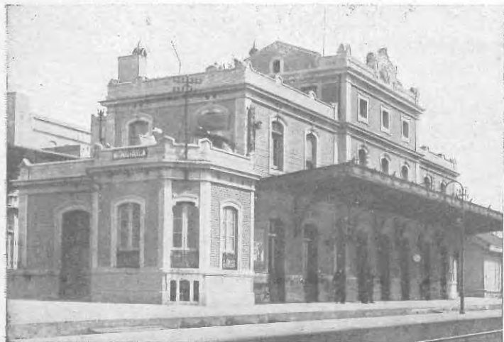
A pesar de su estilo que podríamos llamar reglamentario, la Estación de Masnou-Alella, tiene un sello atractivo.
