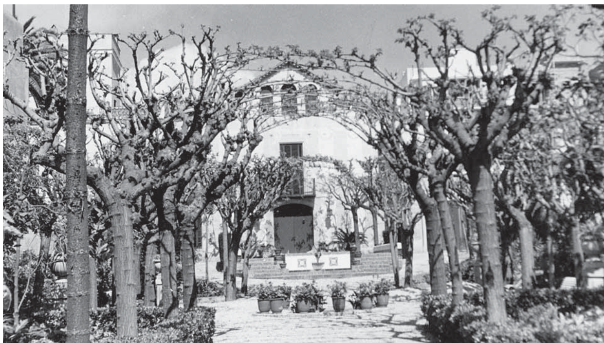
Jardí i façana de la masia Can Casas, en plena tardor. Mitjan segle XX. Autor: desconegut. Núm. de registre: 1331, AMM.
