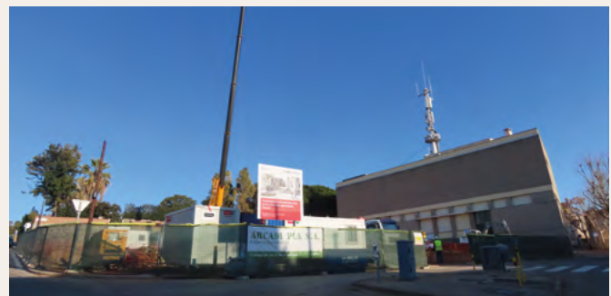
▲ Futura plaça de l'U d'Octubre, on es construeix una promoció d'habitatge protegit. DOMÈNEC CANO
