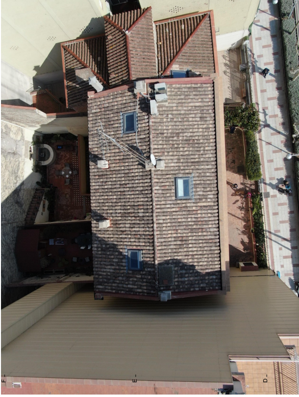
VISTA AÈRIA DE LA COBERTA DEL CARRER BARCELONA 17
