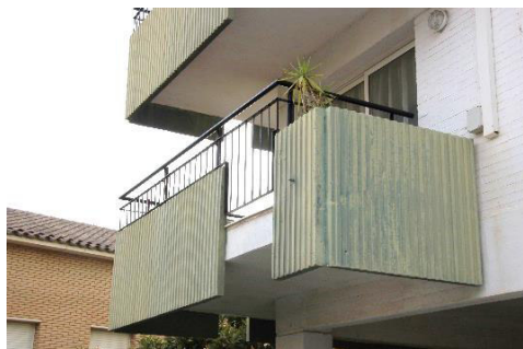
Balcó del bloc A-13 on veiem les baranes metàl·liques i les peces de formigó pintades.
