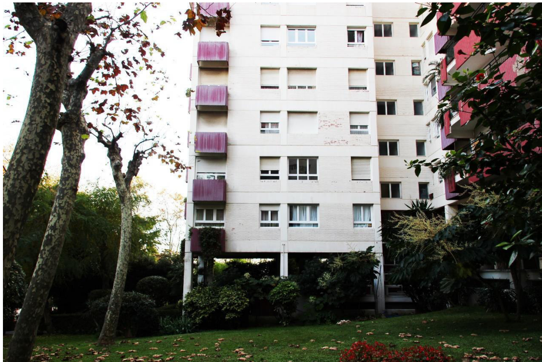
Vista del bloc A-1 amb l'entorn enjardinat.
