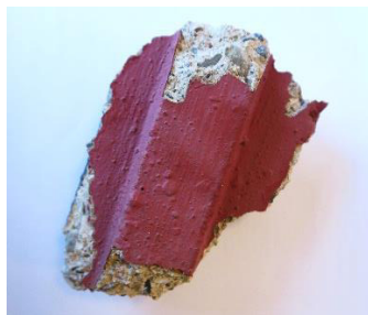
Mostra d'un fragment de formigó pintat després de la façana.
