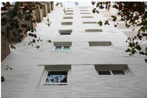
Vista de detall del bloc A-16 on podem veure els acabats de façana.
