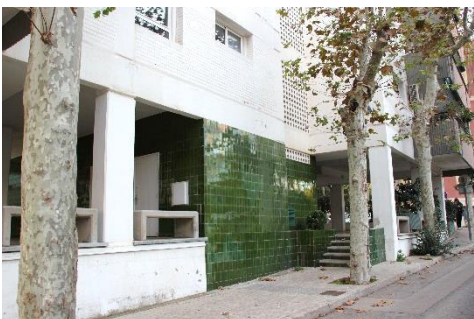
Vista de la part inferior del bloc A-16 on veiem el revestiment de ceràmica vidriada i les diverses situacions de relació amb el pla de façana.
