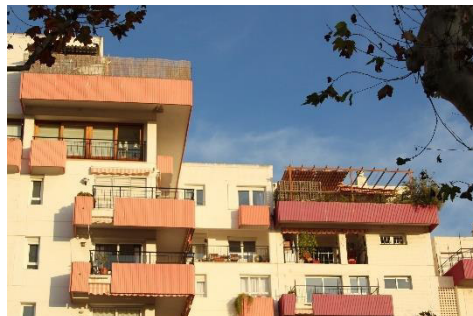
Imatge de la part superior dels blocs A-4 i A-3 on veiem la varietat de les composicions de façana, que s'accentua a les plantes superiors.
