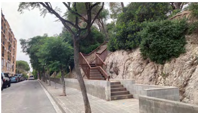
▲ L'orografia abrupta ha dificultat les obres. DOMÈNEC CANO
