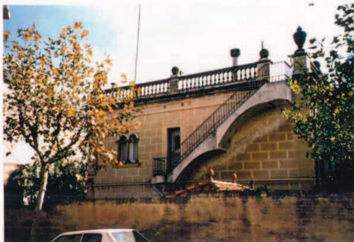
7. FAÇANA CARRER NAVARRA
