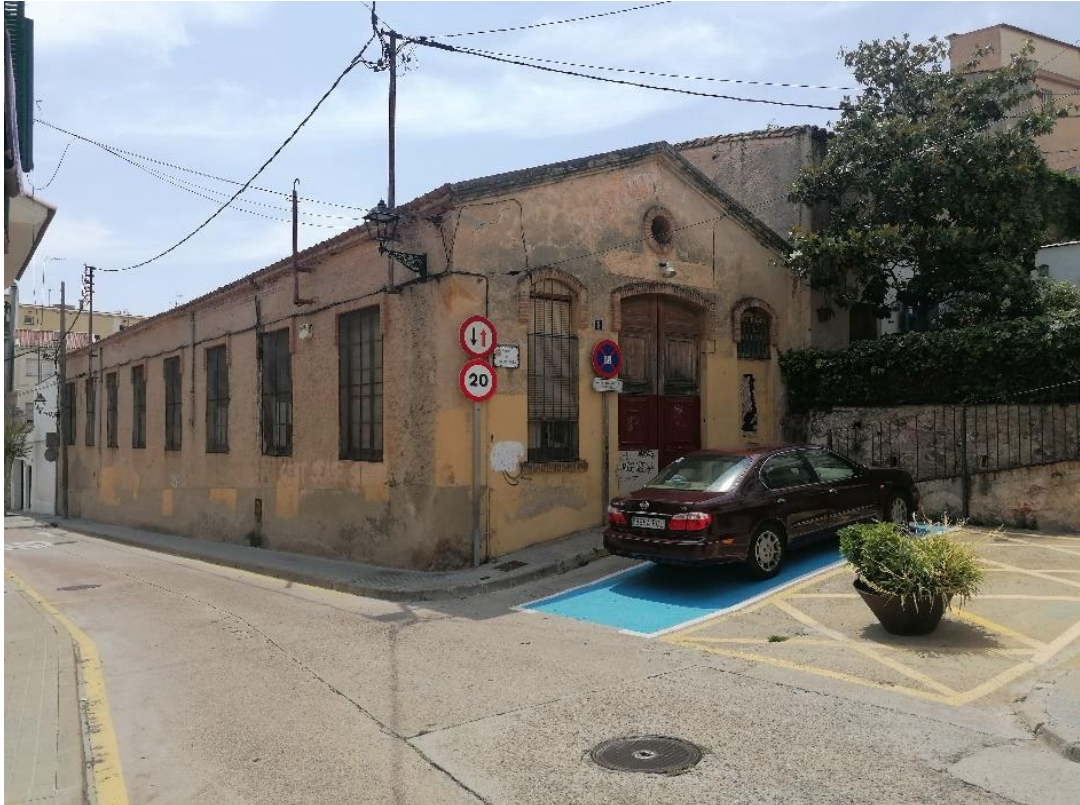
Aspecte exterior de la nau industrial corresponent a una antiga manufactura tèxtil, de planta única rectangular amb coberta a dues aigües i entrada pel carrer de Joan Roig. Foto Rosa Maria Gil. 2023.
