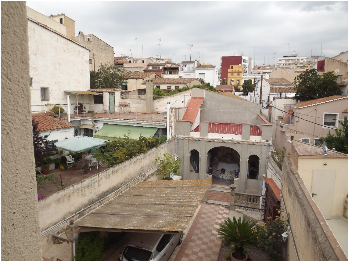
Vista de l'extrem oriental de la Fabriqueta des de la casa veïna pel costat del C/ Bonaventura Bassegoda. Foto: Rosa Maria Gil. 2023.
