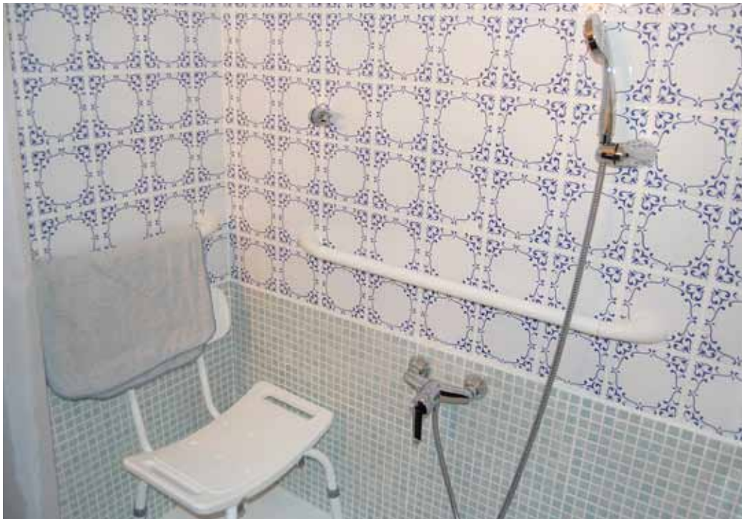
Un domicili arranjat on es va fer el canvi de banyera per plat de dutxa i la instal·lació d'altres d'elements.
