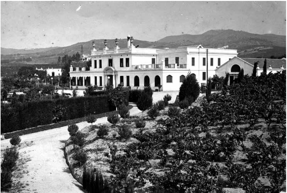
L'edifici del Laboratori el 1925. ARXIU MUNICIPAL DEL MASNOU, FOTOGRAFIA 32138, DONACIÓ DE MARTÍ IGUAL.
