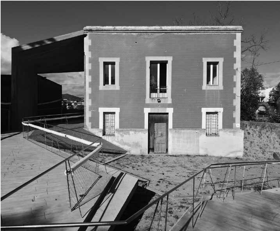
Fotografia actual de la casa dels treballadors on vivien, 2020.
