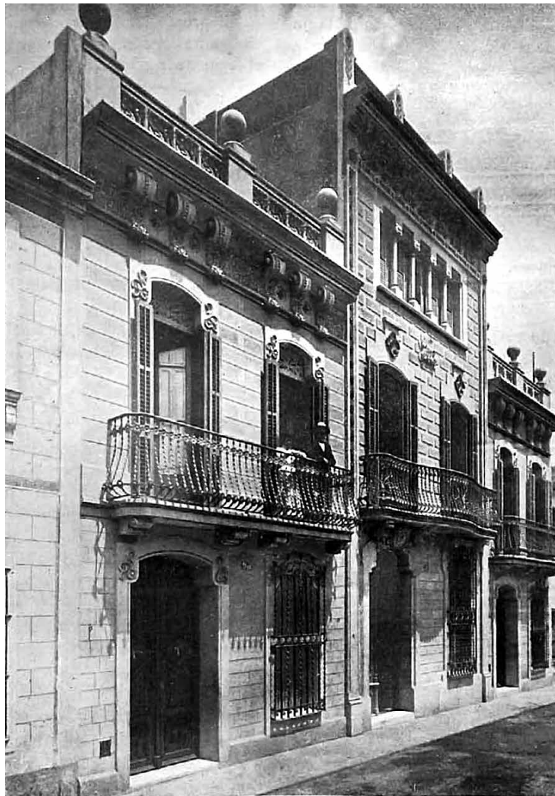
Imatge de les tres cases l'any 1907. Revista Arquitectura y Construcción . Barcelona, març del 1907. Any XI. Núm. 176.
