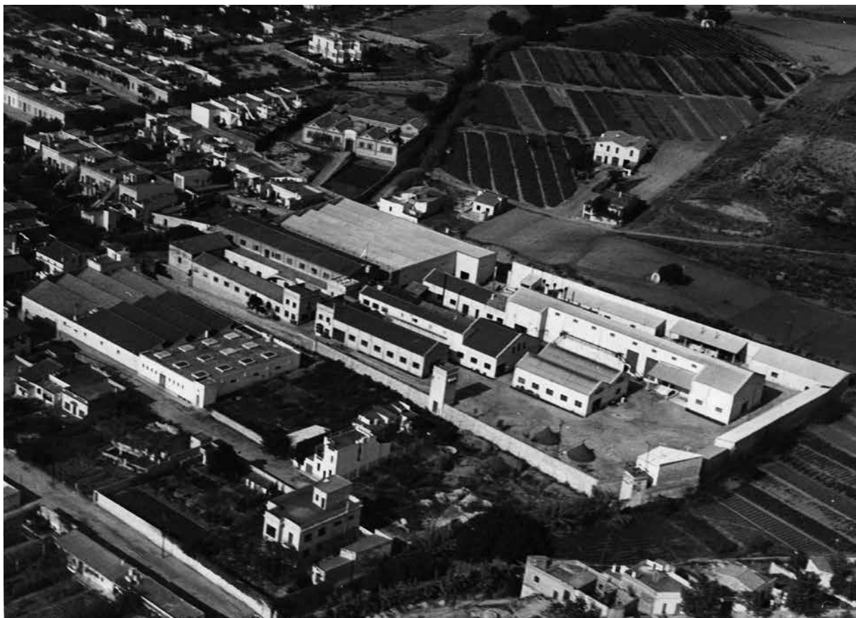
Vista aèria de la fàbrica tèxtil Maristany «Cal Soberano». A dalt, a l'esquerra de la fàbrica, hi ha l'escorxador. 15 de gener del 1950. AHMM. Fons de Francesc Duran Pons, fotografia núm. 15317.
