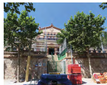
▲ L'Escola Ocata, en obres. XAVI BARCELÓ
