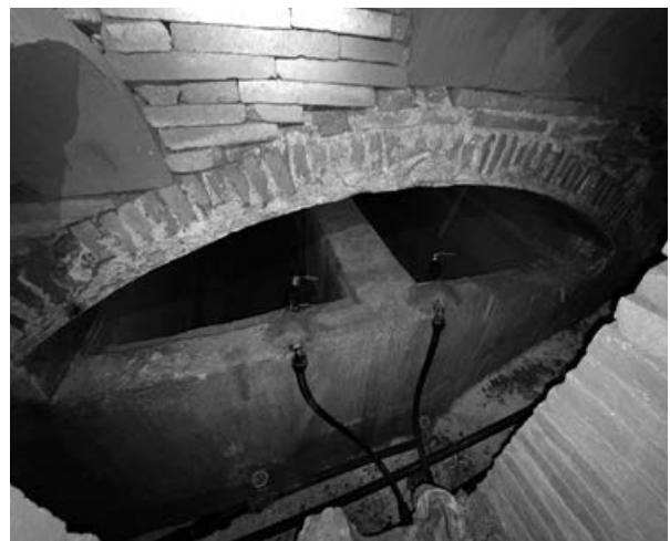
Dipòsits d'aigua de la mina Malet. S'hi observa un arc escarser i la volta catalana que els cobreix. Situat al subsol dels carrers de Roger de Flor i Sant Miquel. Foto: Rosa M. Andrés Blanch.
