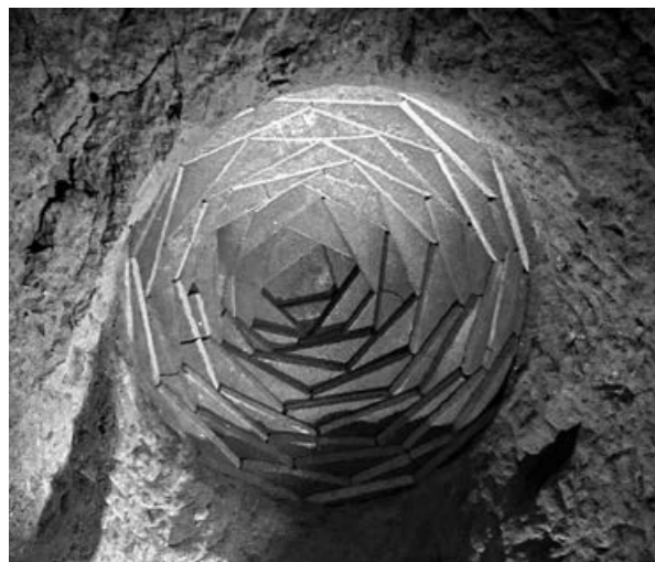
Pou de registre clausurat i cobert per una volta de maons o totxos massissos col·locats en cercles concèntrics fins a tancar una petita cúpula anomenada garlanda . Foto: Rosa M. Andrés Blanch.
