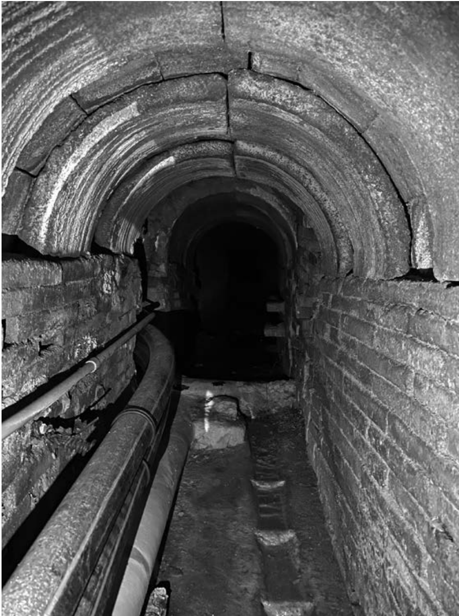
Galeria de la mina Cresta on es poden observar canonades de diferents períodes, així com una canaleta que data de l'època de construcció de la mina, situada arran de terra sense cap tipus de llosa de cobriment. Foto: Rosa M. Andrés Blanch.
