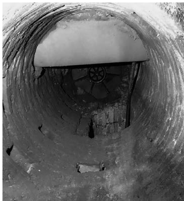
Pou de registre. Interior de la galeria Malet, que va per sota del carrer de Jaume I. Es pot veure la tapa del pou que connecta amb la superfície, una galeria a un nivell superior que el travessa i els forats a les parets del pou per poder pujar i baixar apuntant-hi peus i mans. Foto: Rosa M. Andrés Blanch.
