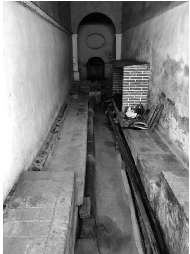
Repartidor general de la mina Murot-Patrana i accés principal, situat al carrer de Lluís Millet. Foto: Rosa M. Andrés Blanch.
