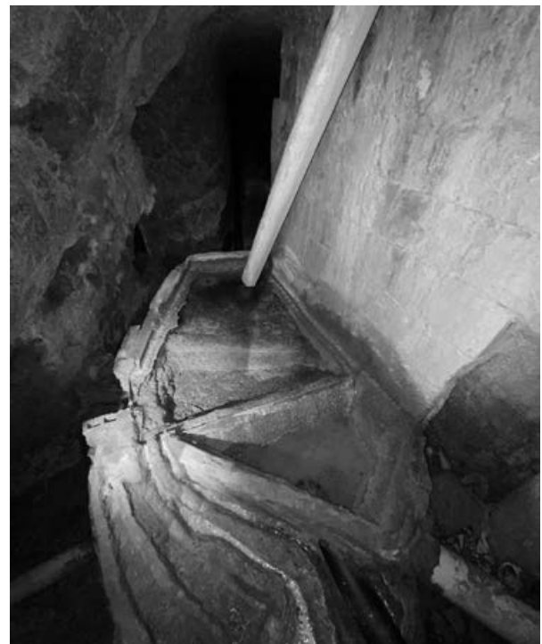
Pericó situat a l'interior de la mina Murot-Patрана. És una arqueta de distribució d'aigua, feta d'obra. Foto: Rosa M. Andrés Blanch.
