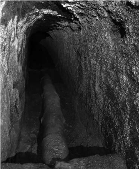
Galeria interior de la mina Cresta. Excavada directament sobre el sauló. S'hi pot observar una canonada cilíndrica de ceràmica i una petita concavitat a la paret destinada a penjar-hi el llum d'oli o de carbur. Foto: Rosa M. Andrés Blanch.
