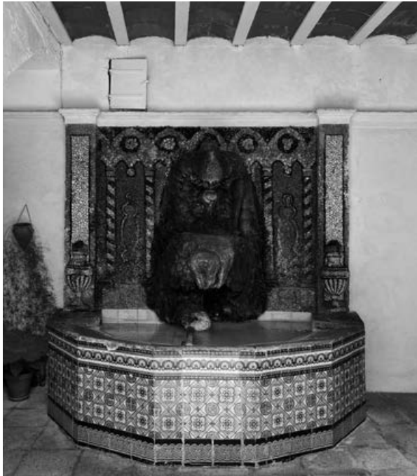
Safareig adossat a la paret del fons de l'eixida situat sota un terrat. Dividit en dues piques, per rentar i per esbandir o per a altres usos. Decorat amb rocalla de pedres petites de diferents colors. El dipòsit és al darrere, sota el carrer, i quan és ple, l'aigua raja per un sobreexidor que forma una petita font. Casa de cos del carrer dels Mestres Villà. Foto: Rosa M. Andrés Blanch.
