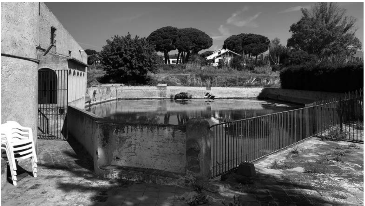
L'aigua de la mina de Can Teixidor arriba a una gran bassa de 565 metres quadrats i una capacitat de 1.200 m 3 , situada sobre un molí fariner. Forma part del conjunt arquitectònic construït fonamentalment entre els segles XVII i XIX. Foto: Rosa M. Andrés Blanch.
