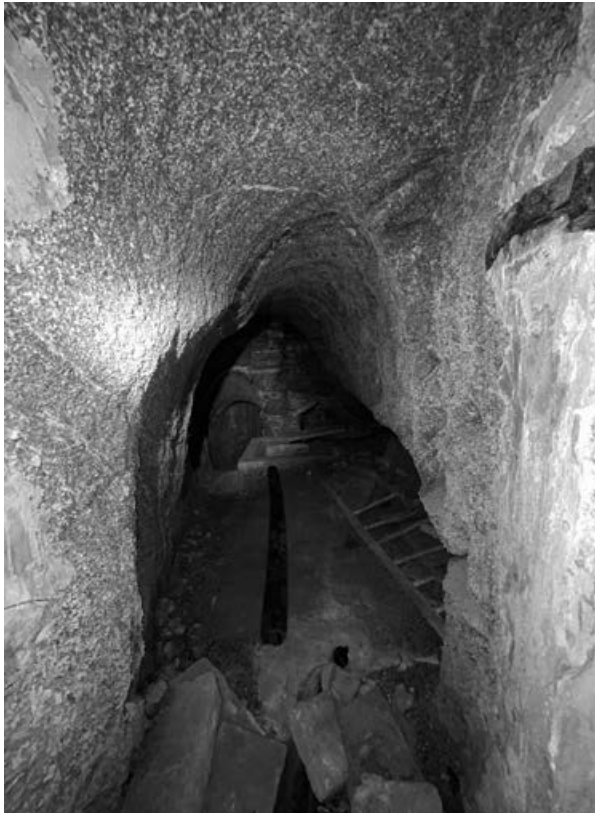
Mina Murot-Patrana. Al fons de la galeria s'hi poden observar les portes d'entrada a la mina des de dues cases particulars. Per aquesta galeria es té accés al dipòsit d'aigua de la casa, que pot estar entre els 10 i els 100 metres de distància. Foto: Rosa M. Andrés Blanch.
