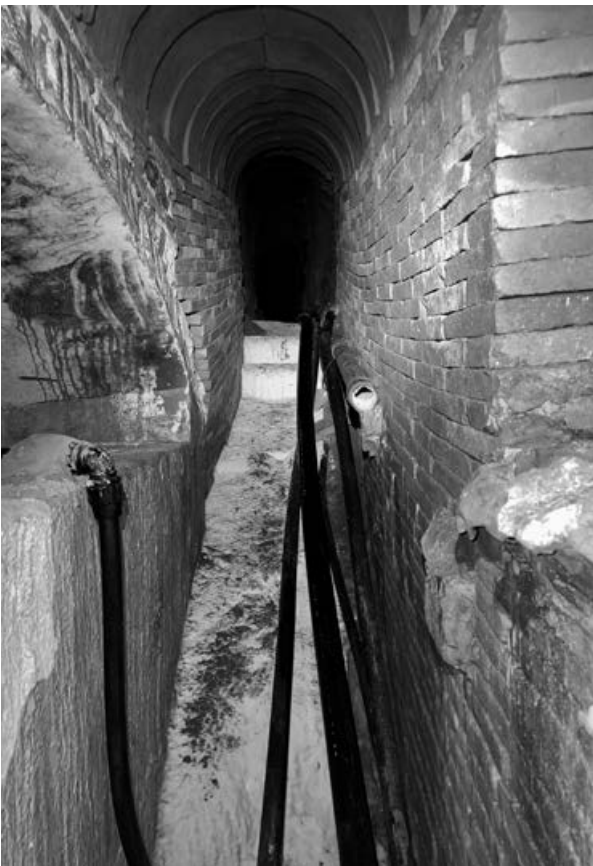
Dipòsit d'aigua de la mina Malet. Situat al subsol dels carrers de Roger de Flor i Sant Miquel. S'hi pot veure la calç dipositada al sòl de la galeria. Foto: Rosa M. Andrés Blanch.
