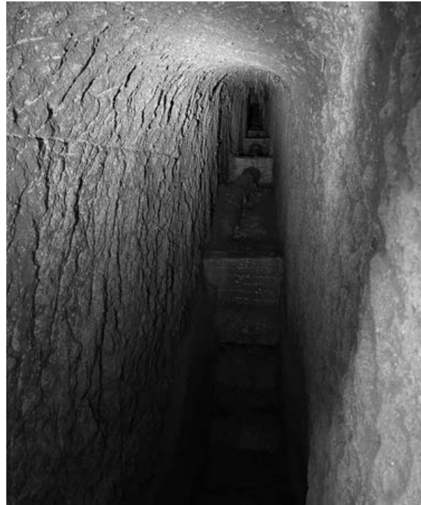
Galeria interior de la mina Cresta localitzada a la plaça d'Ocata. Excavada directament sobre el sauló. S'hi observen uns graons per salvar el desnivell i petites arrels que travessen el sostre. Foto: Rosa M. Andrés Blanch.
