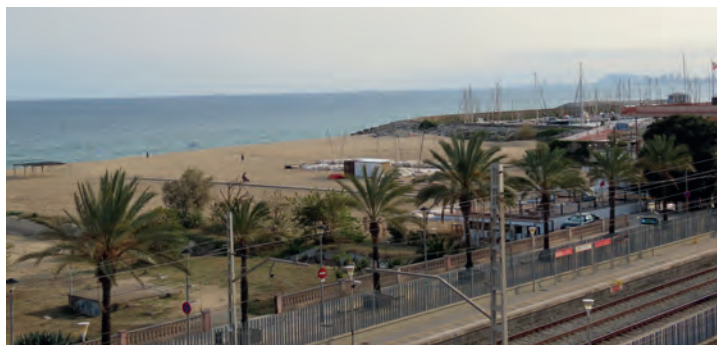
▲ L'espigó s'havia projectat com a continuació del dic de recer del port, transversal a la línia de costa. DOMÈNEC CANO
