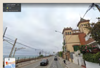
▲ Tram que hauria resultat afectat. GOOGLE STREET VIEW
