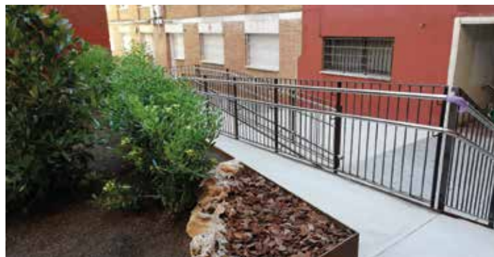
▲ La instal·lació de baranes i l'enjardinament del parterre van culminar l'obra. AJUNTAMENT
