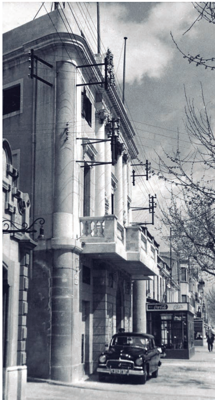
Vista antiga de l'edifici de l'Ajuntament del Masnou, construït a partir del projecte encarregat l'any 1844 per l'alcalde Joan Rubis a l'arquitecte Miquel Garriga i Roca, en uns terrenys adquirits per la família Malet el 1755. AMM, 122.
