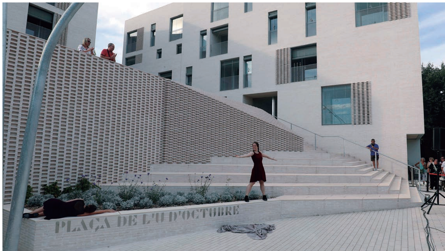
La plaça de l'U d'Octubre, inaugurada el 2024, és un espai públic renovat que substitueix l'antiga caserna de la Guàrdia Civil i incorpora habitatges de protecció oficial.
