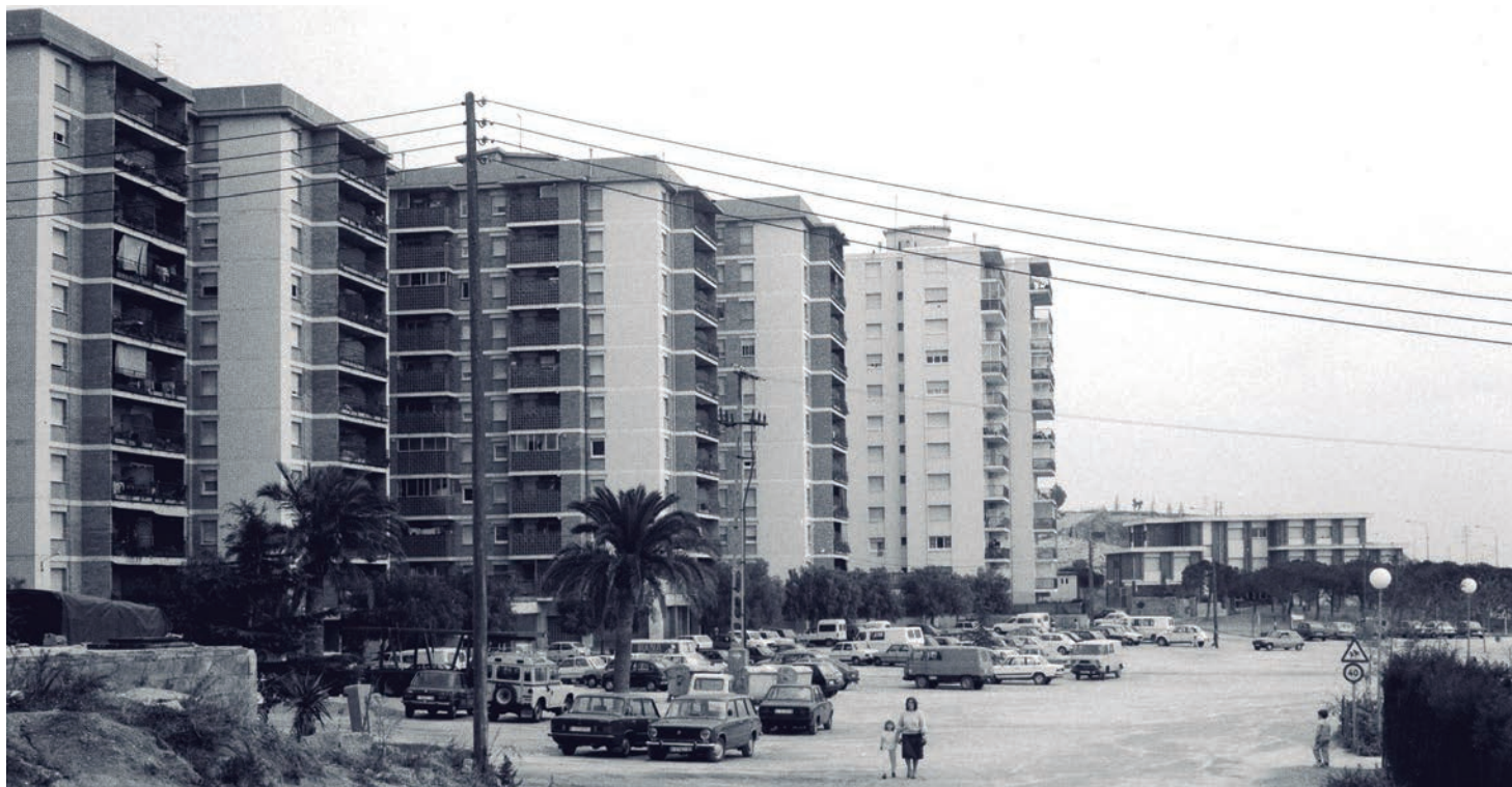
A partir dels anys seixanta, el creixement poblacional, impulsat per la immigració, va transformar l'urbanisme del Masnou, amb l'enderrocament de finques velles i l'arribada de nous edificis de diverses plantes. AMM, 11814.
