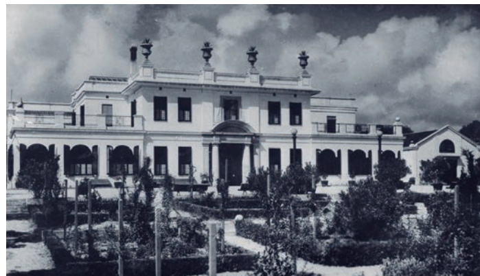
Laboratoris del Nord d'Espanya, vista general (1930-1939). Freytas. AMM, 18615.
