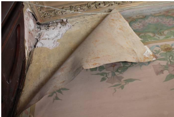
Despreniments dels suports
