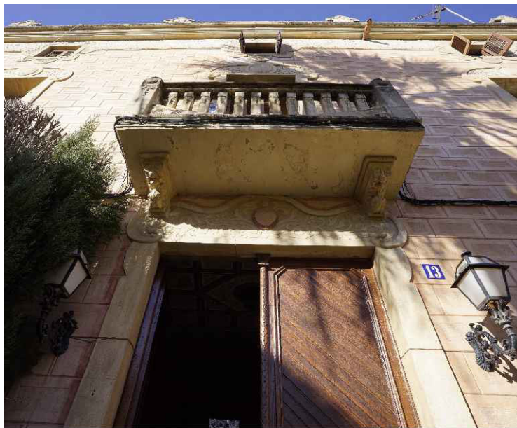
04-IMATGE BALCÓ PRIMERA PLANTA-FAÇANA PRINCIPAL
